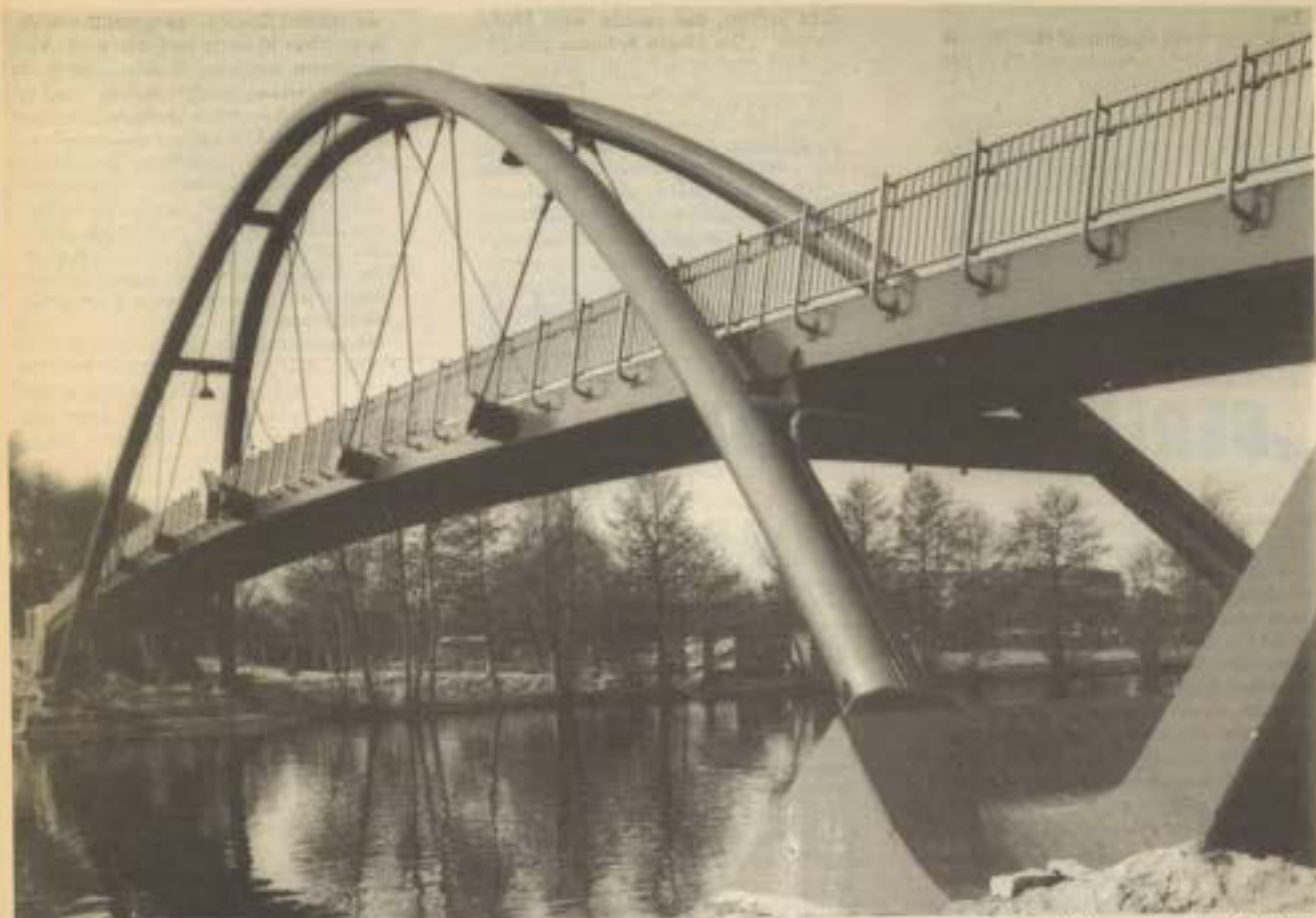
Fußgängerbrücke über den Hohenzollerkanal, Berlin
